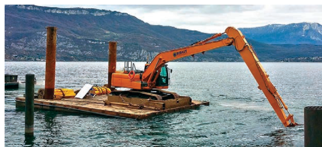
Dragage mécanique réalisé à l'aide de pelles montées sur des barges
