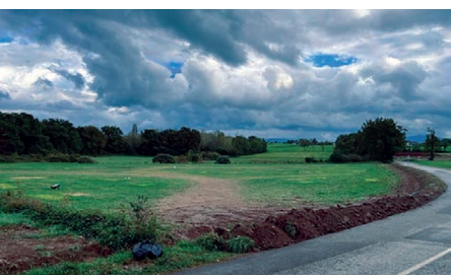
Les tranchées de Nernier
