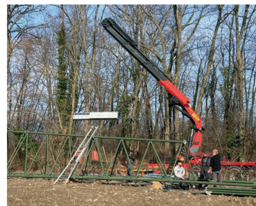
Montage de la nouvelle antenne 4G
