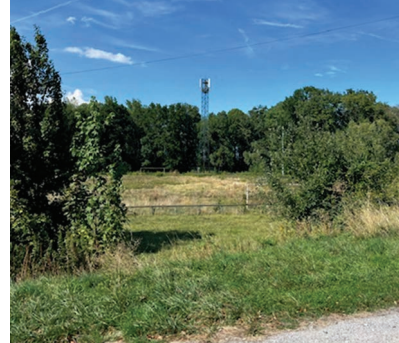
Insertion du pylône de 30 m, type treillis couleur vert olive dans le paysage
